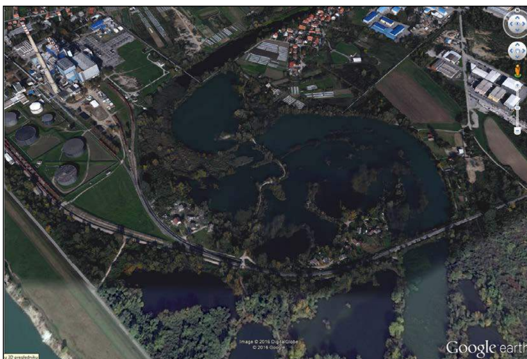
Sl. 2.2-11: Jezero Savica u neposrednoj blizini TE-TO Zagreb sjeverno i južno od željezničkog industrijskog kolosijeka
